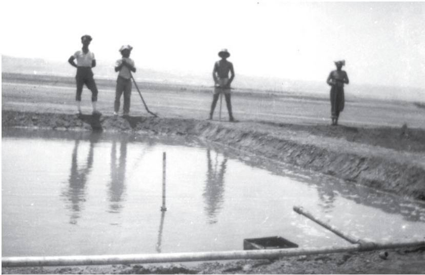
איור 4: בריכות אידוי ניסיוניות בצפון ים המלח, 1928: א. חופרים ברכה ראשונה; ב. ממלאים במי ים־המלח במשאבת־יד (אוסף לנגוצקי)
